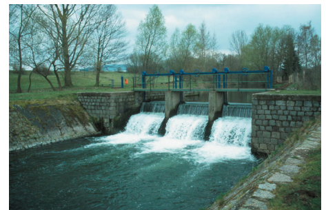
Beeinträchtigung der Durchgängigkeit durch Wehranlagen als unpassierbare Querbauwerke
