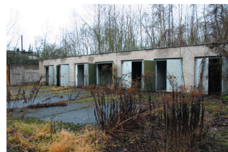
Vorbelastungen des Plangebietes durch diverse Altlasten (Munitionsdepot, Tankstelle etc.)
